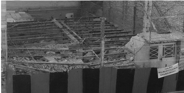
شکل ۸-۱ جمع آوری نخاله‌های ساختمانی و آماده سازی برای برش اسکلت
