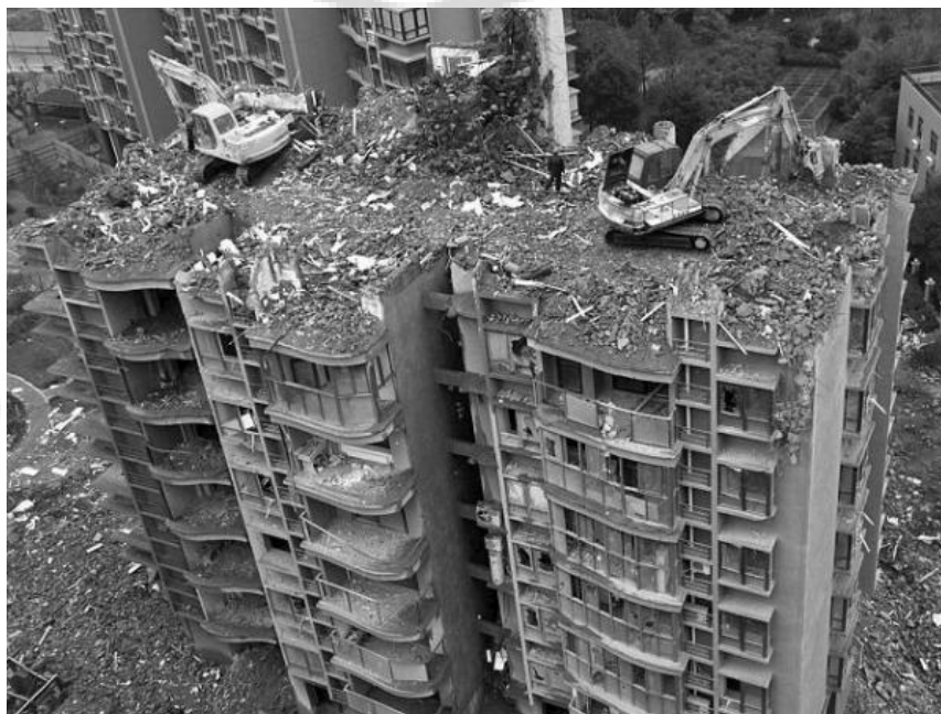
شکل ۱-۱ تخریب مکانیکی ساختمان مرتفع از بالا به پایین
