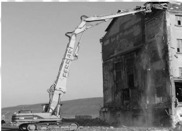
شکل ۴-۱ تخریب با فیچی هیدرولیک
