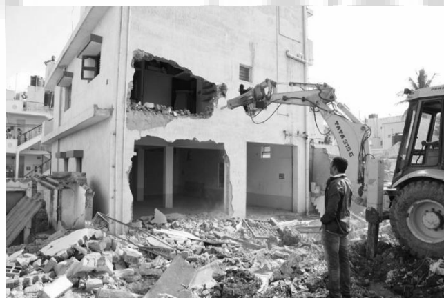
شکل ۳-۱ تخریب ساختمان با پیکور
