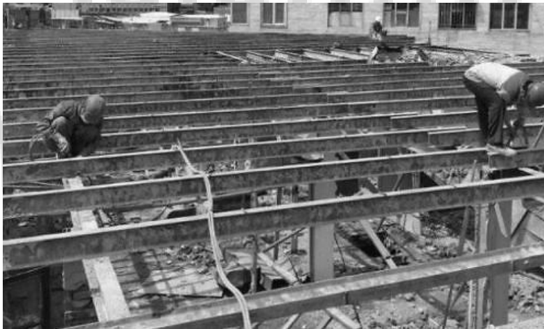
شکل ۹-۱ برش آهن آلات اسکلت با هوا برش
