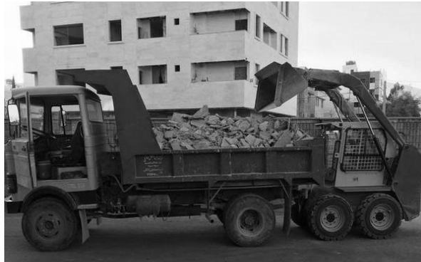
شکل ۱-۱۰ بارگیری و حمل نخاله‌ها به بیرون کارگاه
