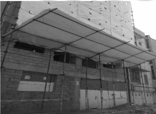
شکل ۱-۱۱ نحوه اجرای حفاظ ایمنی موقت
