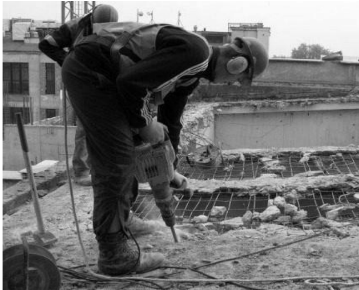
شکل ۷-۱ تخریب دستی سقفها از بالاترین نقطه ساختمان
