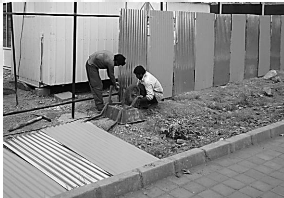
شکل ۱-۶ محصور کردن محوطه کارگاه قبل از تخریب
