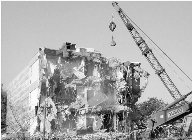
شکل ۱-۵ تخریب با استفاده از ضربه گوی فلزی
