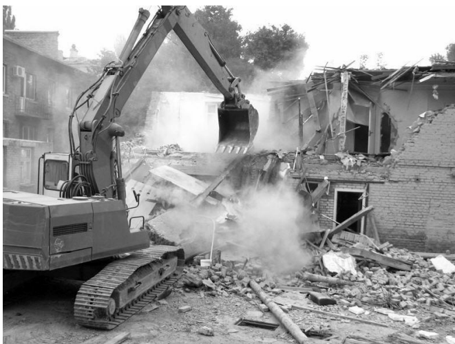
شکل ۲-۱ تخریب مکانیکی توسط بیل مکانیکی
