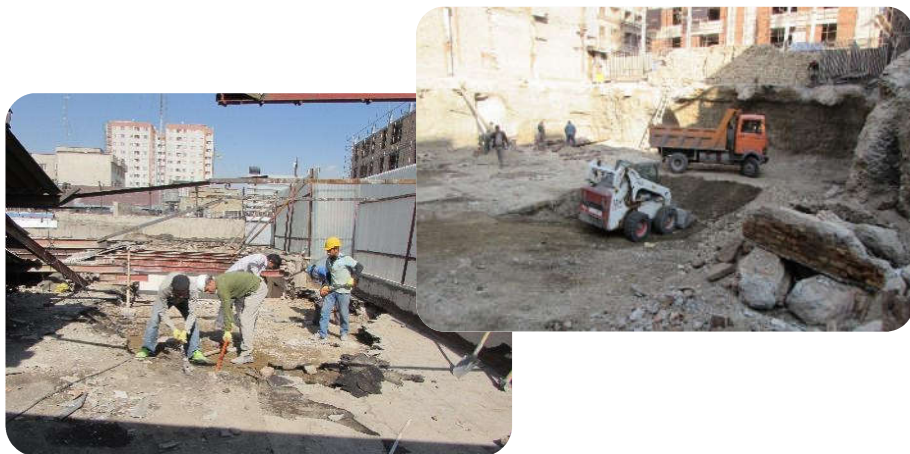
تخریب، گودبرداری و تسطیح محوطه
