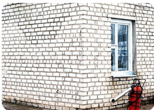
اجرای دیوار با آجر ماسه آهکی
